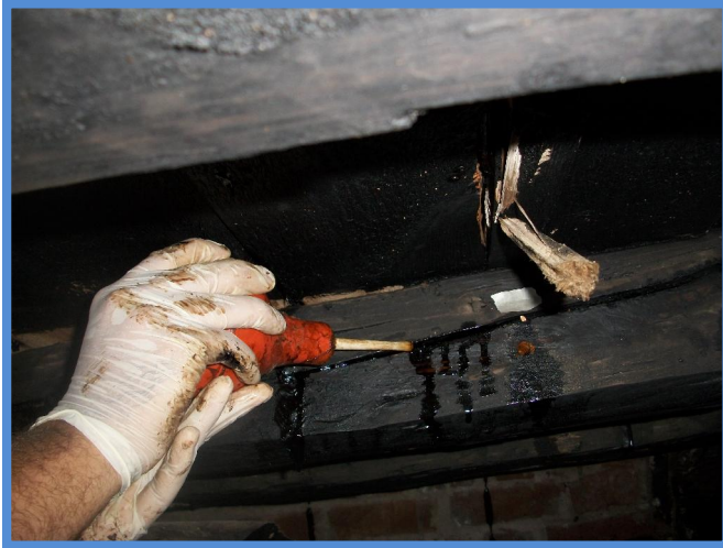
ضغط المبيد بالأخشاب باستخدام مضخة
