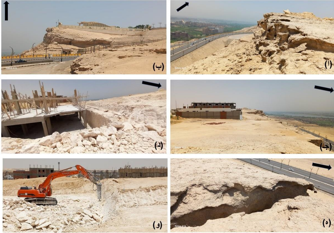
لوحة (1) صور فوتوغرافية توضح مسار الطريق الأوسط والإنشاءات العمرانية على حافة الهضبة الجيرية المواجهة لمدينة المنيا وأعمال تسوية السطح والفوالق
