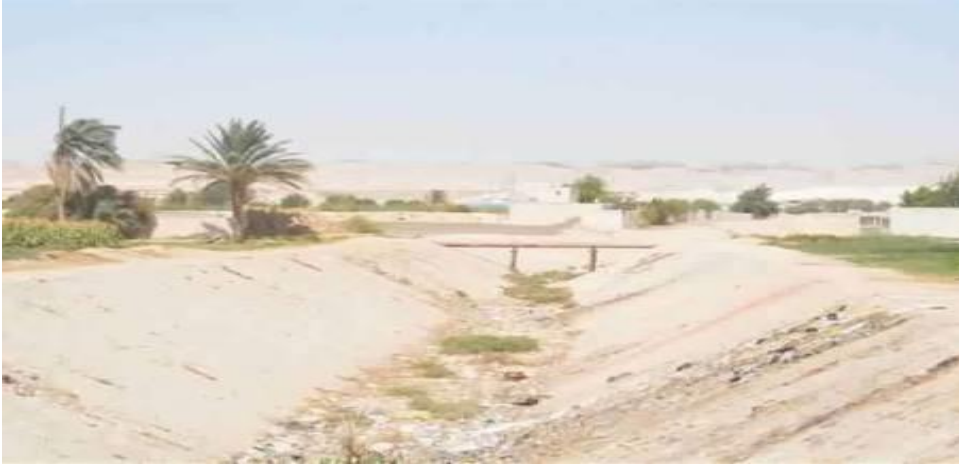
صورة ( 3 ) مخر مبطن بالحجارة لتصريف مياه السيول التقاط الصورة في 8 مارس ، 2015 ، النظر في اتجاه الغرب .
